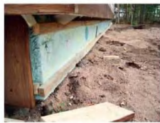
Наружное утепление фундамента плитами ЭППС.
