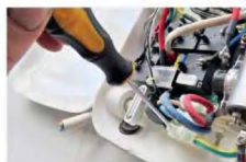
Откручиваем винты в соединительной колодке, чтобы вынуть обрезок старого провода.
