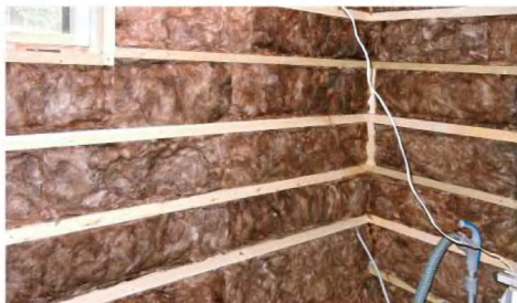
Внутреннее утепление дома утеплителем на основе стекловолна.
