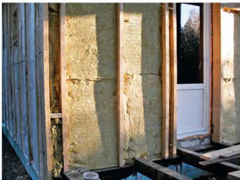
Наружное утепление стен дома из газобетона.
